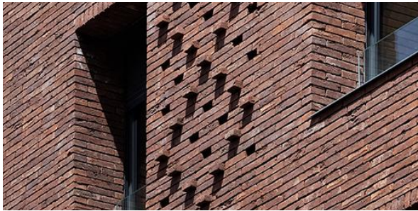
GEVEL - baksteen accenten
