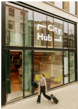
PLINT - portaal en verdeling met stalen profielen, en staallook aluminium pui RAL 7045 (Tele grijs)
