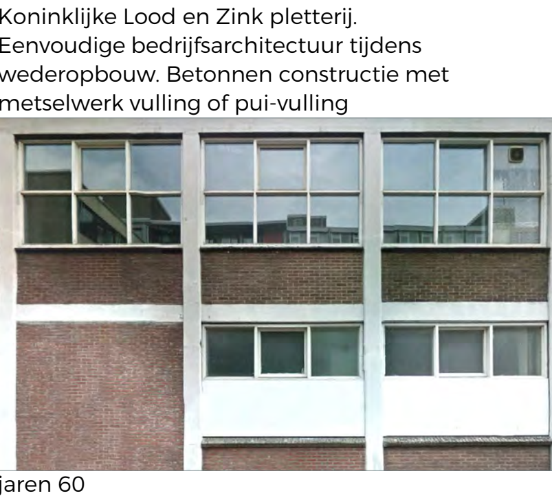
Behangselpapierfabriek van de firma Hulst. Gebouwd in de middenstrook van het dubbele expeditiehof. Sloot wel de 1e Blekerhof af, maar niet de Hoornbrekerstraat. Koninklijke Lood en Zink pletterij. (wordt gesloopt) Betonnen constructie met metselwerk vulling en typische lamellengevel.
